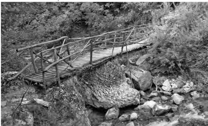
Ponte del Vallone
